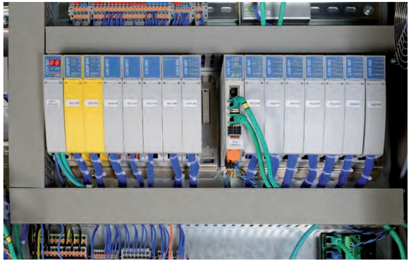
Besturingsmodules met snelle C-Dias I/O van Sigmatek kunnen via het hard real-time Varan netwerk snel communiceren
