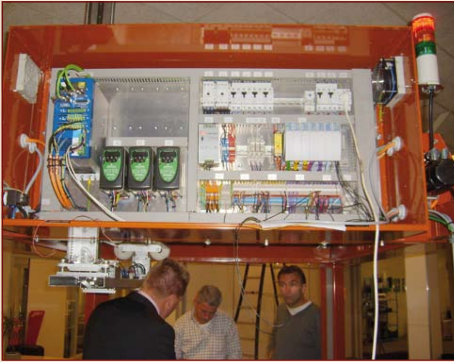
Voor de besturing van de Linea Recta is opmerkelijk weinig hardware nodig, wat zich vertaalt in deze kleine besturingskast.
