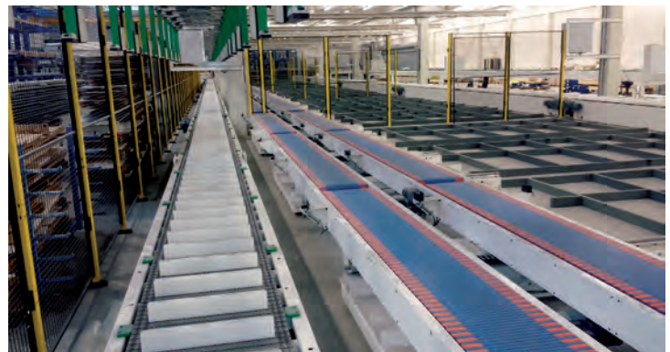
Laatste stap in het traject is de assemblage waar de panelen worden opgelegd op een afvoersysteem en samengevoegd worden met zogenaamde 'hamburger'-pakketten met overig montagemateriaal.
