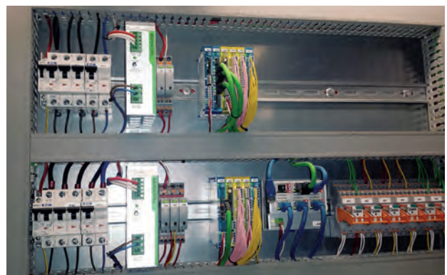
De S-Dias met CPU en safety I/O is gekoppeld aan het hard real-time VARAN netwerk met behulp van splitter modules.
