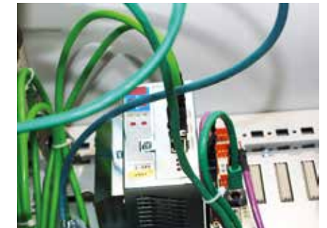
De C(compact)-IPC communiceert net zoals de overige SIGMATEK onderdelen via de hard real-time VARAN Ethernet-bus.
