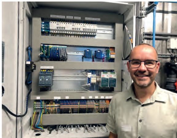
Johan Craemers van JC Techniek tekende voor de implementatie van de besturing van de Blauwe Watertuin. Achter hem zie je de uiterst compacte modules van SIGMATEK, analoge en digitale I/O met safety.
