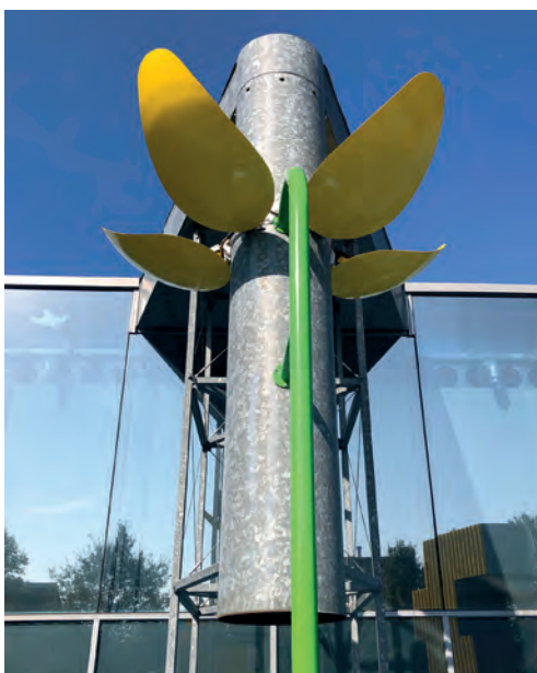
Voor de toiletspoeling vangt Hidrodoe regenwater van het dak op via de waterspuier, die in de Blauwe Watertuin uitkomt.
